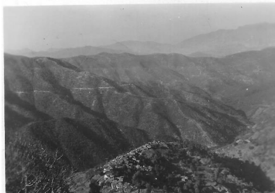
Village de Manzekouane avant déboisement au col de Sidi Chaban à la naissance de l'oued Djabira
