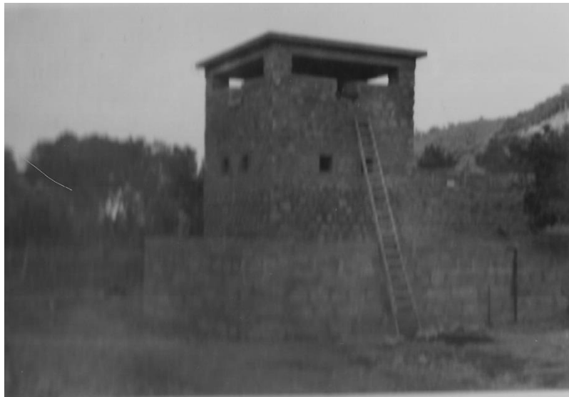
Station de pompage eau potable à Bougie
